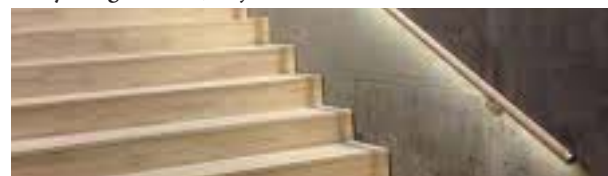
Tunnelnedgang, belysning i håndlister
