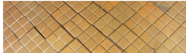
Gulvklinter afrenses og repareres
