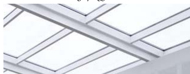
Belysning med ovenlyseffekt i tunnel
