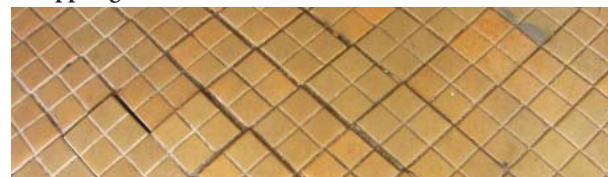
Gulvklinter afrenses og nylægges
