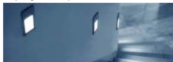
Tunnelnedgang, punktbelysning på trampe
